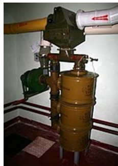
Şəkil 6.13. Süzücü-ventilyasiya sistemi
