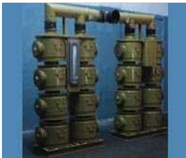
Şəkil 6.13. Süzücü-ventilyasiya sistemi
